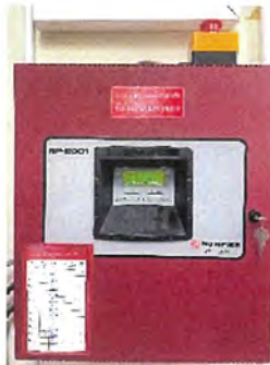
ภาพที่ 2.2-48 ระบบ Deluge Sprinkler และ Fire Detector ที่ถังเก็บกากเมทานอล
