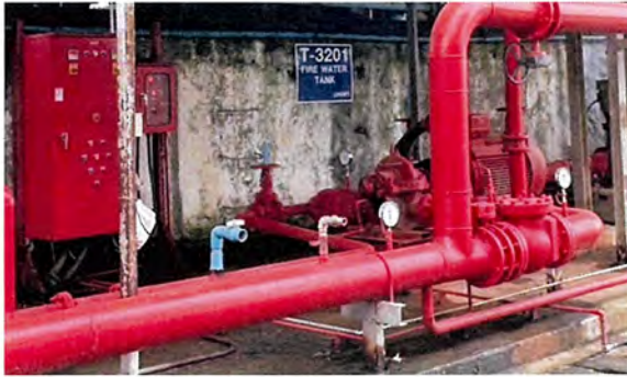
ภาพที่ 2.2-58 เครื่องสูบน้ำดับเพลิงและถังเก็บน้ำสำรองดับเพลิง
