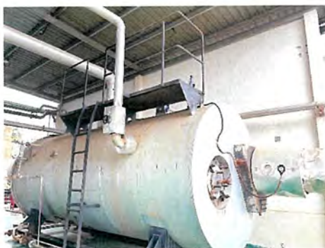
ภาพที่ 2.2-1 หม้อไอน้ำสำเร็จรูป Package Boiler
