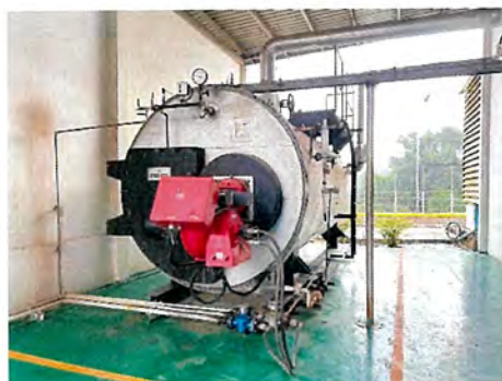
ภาพที่ 2.2-1 หม้อไอน้ำสำเร็จรูป Package Boiler
