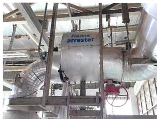
ภาพที่ 2.2-50 Flame arrester
