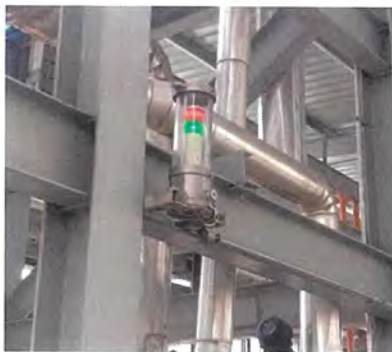
ภาพที่ 2.2-49 อุปกรณ์ตรวจจับเปลวไฟบริเวณท่อ ระหว่างเครื่องระเหยกับถังปฏิกริยา
